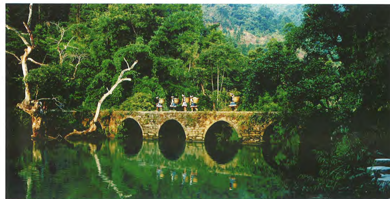
Il ponte a sette archi di Libo
